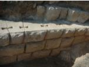
Տիգրանակերտի միջնաբերդի ծիծեռնակապուշ շարվածքով պարիսպը, մ.թ.ա. 1-ին դար Tigranakert citadel's wall with "swallow-tail" ties, 1st c. BC
