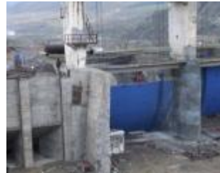
Հիդրոէլեկտրակայանի շինարարություն Մարտակերտի շրջանում Construction of hydroelectric of Martakert region
